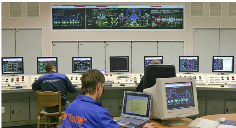
Отладка АСУ ТП энергоблока № 4 Березовской ГРЭС
